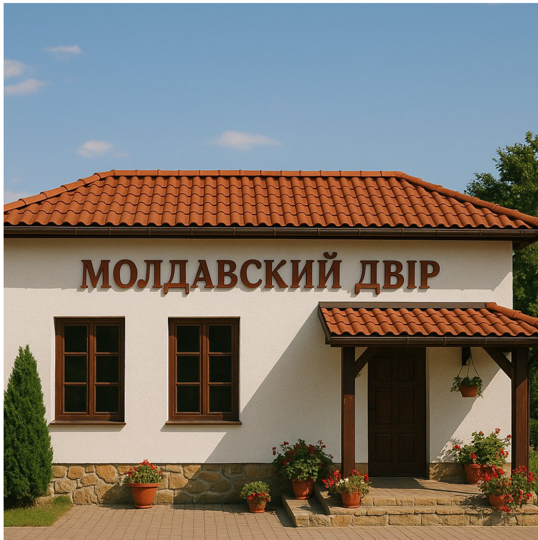
Рис.2.1. Фрагмент ектер'єру будівлі ресторану «Молдавський двір»
